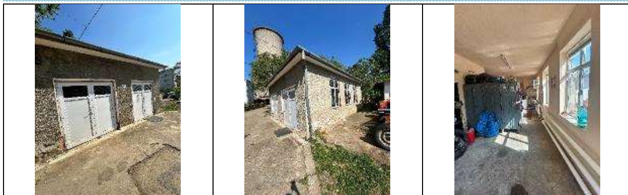
359602-C10 – Clădire din zid (PSI)
